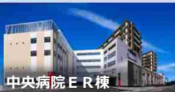
中央病院ER棟
