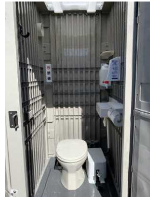
快適トイレ（球磨村での水害時における設置事例） 提供：特定非営利活動法人日本トイレ研究所
