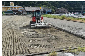
レーザーレベラーでの施工
