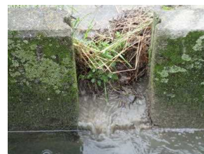
右 緩傾斜ほ場 緩傾斜ほ場の排水の状況
