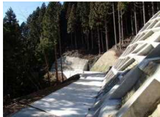
緊急輸送道路を補完する林道
