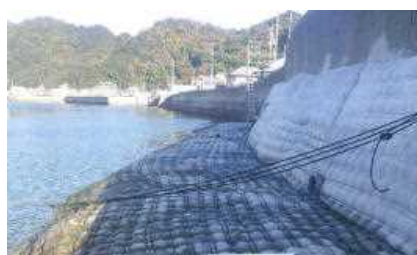
海岸整備 (土佐泊漁港海岸・護岸)
