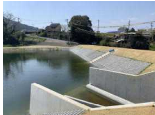
整備された農業用ため池
