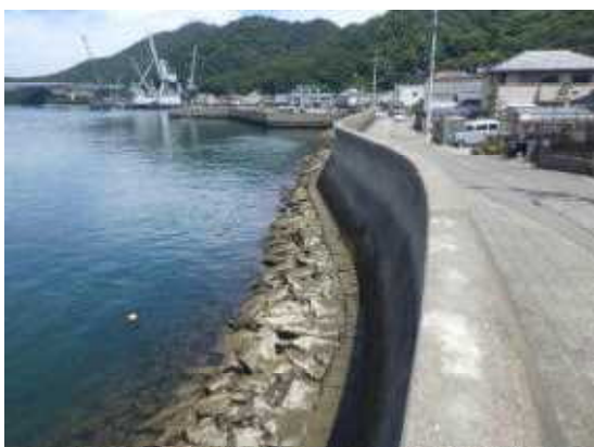
漁港海岸・護岸補強（整備前）
