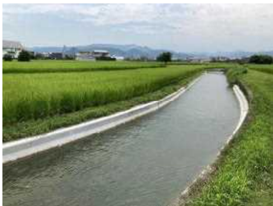
平島幹線水路（那賀川地区）
