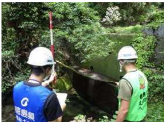
山地災害危険地区パトロール
