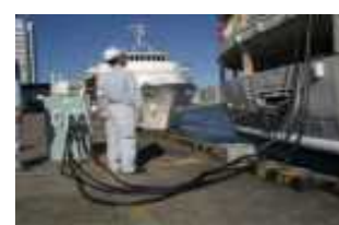
係留船舶への陸上電力供給
