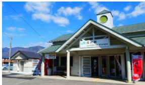
貞光駅公衆トイレ（左）
