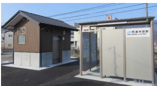
阿波半田駅公衆トイレ（左）
