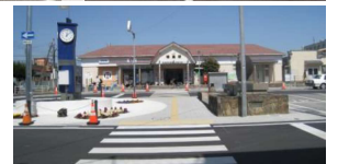
鴨島駅ロータリー整備
