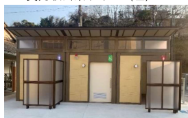
穴吹駅公衆トイレ
