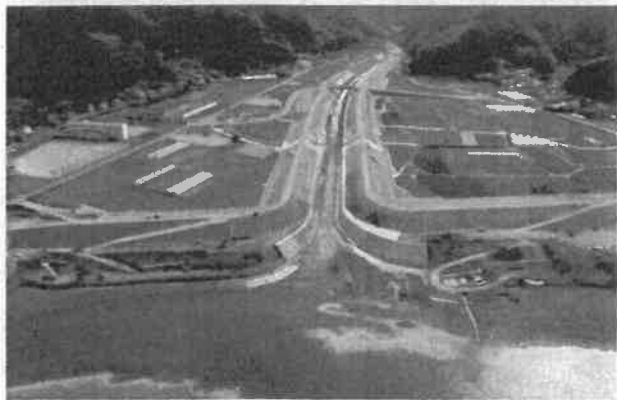
那賀川床上浸水対策特別緊急事業（加茂地区）
