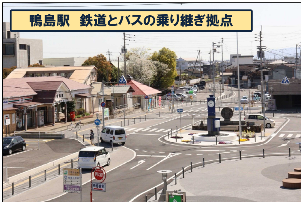
JR徳島線「鴨島駅」 ロータリー整備 令和3年度完成 事業主体： 吉野川市
