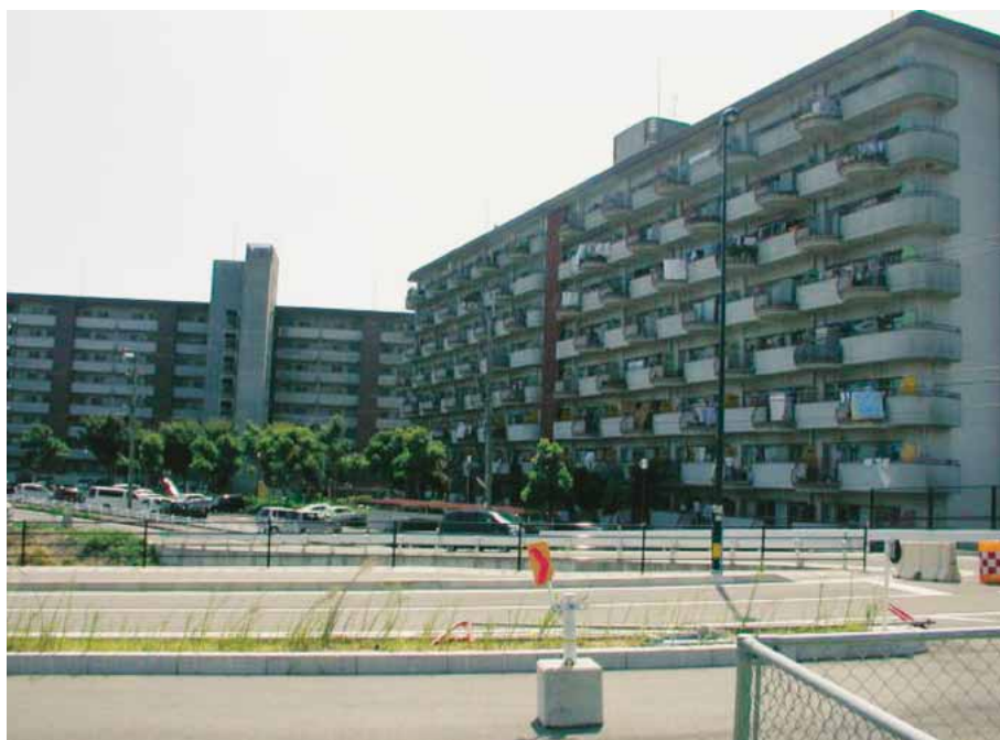
耐震改修が必要な金沢団地6・7号棟（S.53年建設：144戸）
