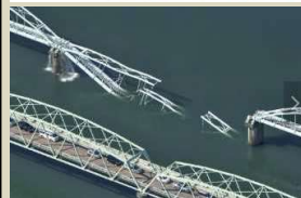
R3.10 和歌山県 「六十谷水管橋」崩落
