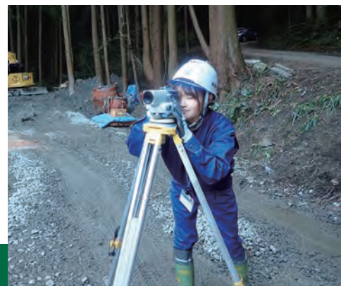
▲ 施工状況(基準高)確認
