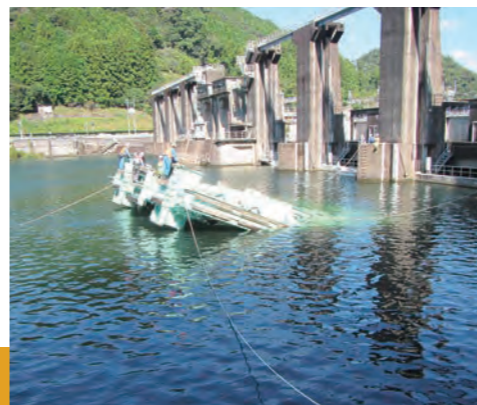
▲浮きゲート装着作業
