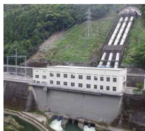
日野谷発電所
