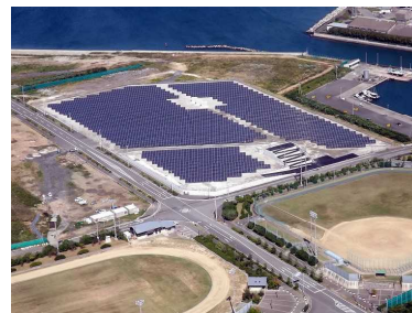
和田島太陽光発電所
