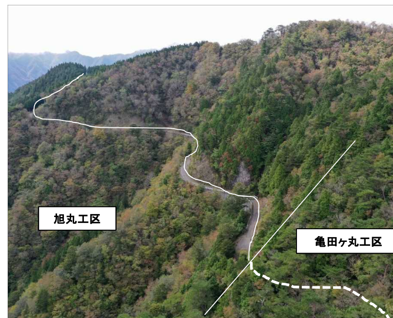
工区間の接合部
