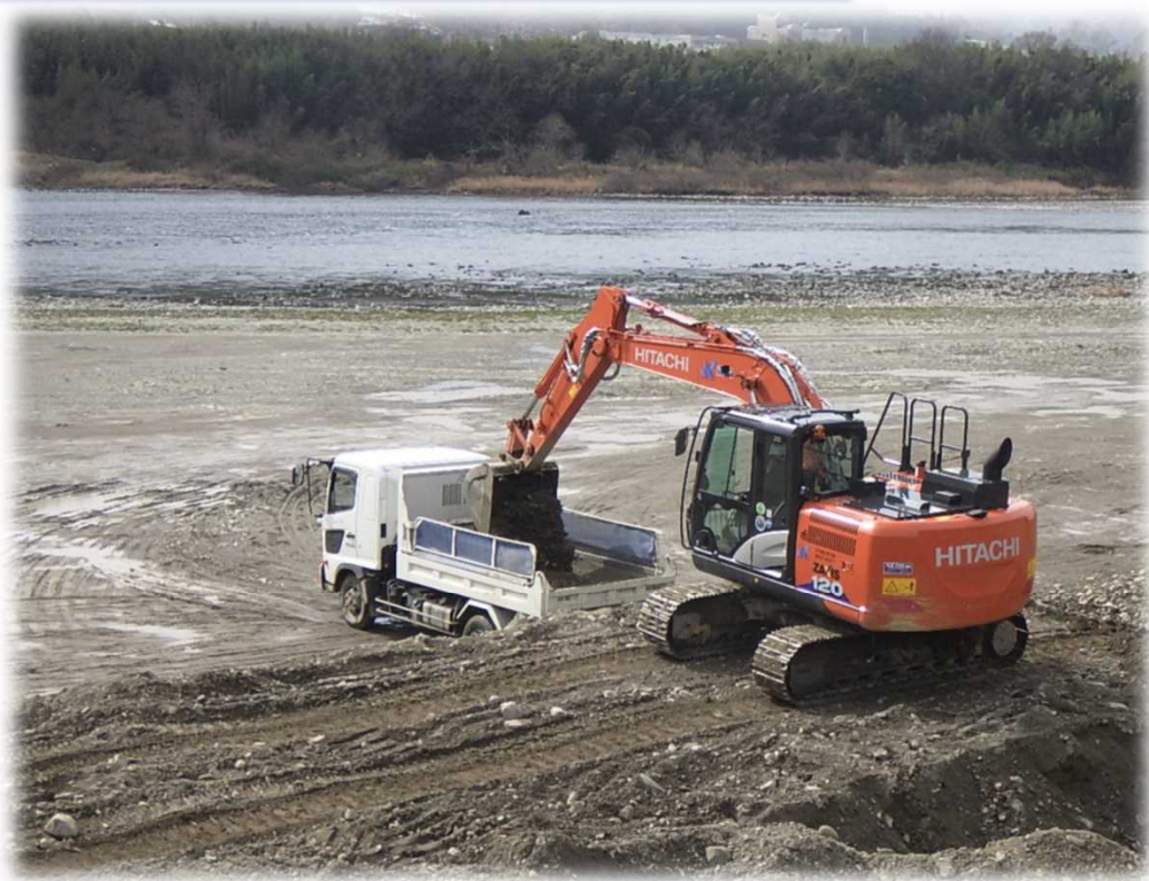
河川掘削残土の積込状況
