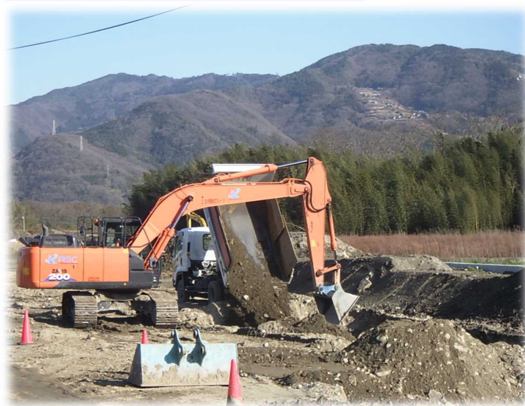
河川掘削残土の運搬・投入状況
