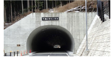
<下瀬2号トンネル>
