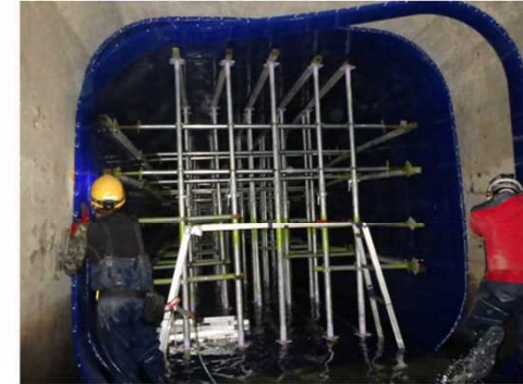
整備状況 鳴門市 撫養排水区 長寿命化対策
