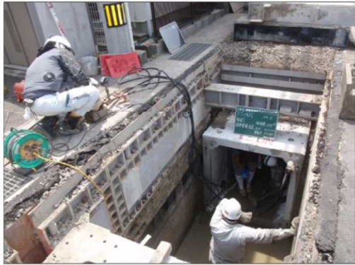
整備状況 徳島市 田宮西排水区
