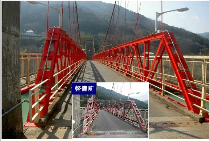
整備後 (一) 屋間辻線 美濃田大橋 (橋梁修繕)
