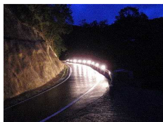
那賀町小水力（街灯）
