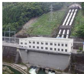
日野谷発電所
