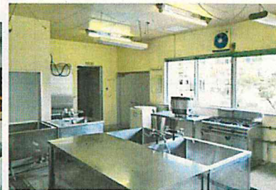
厨房（電子レンジ、ガスレンジ、冷凍冷蔵庫、ガス炊飯器等）
