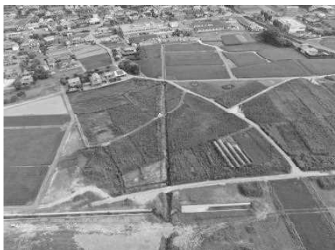
ほ場整備（沼田地区）着手前
