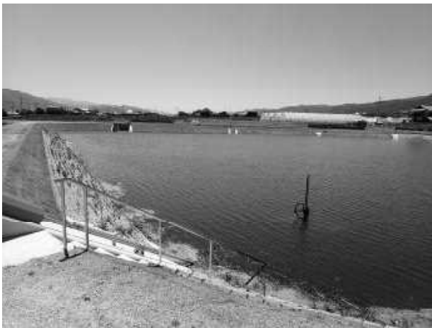
整備された農業用ため池
