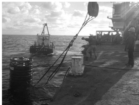
中層型浮魚礁の設置
