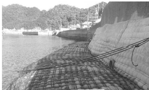
海岸整備（土佐泊漁港海岸・護岸）
