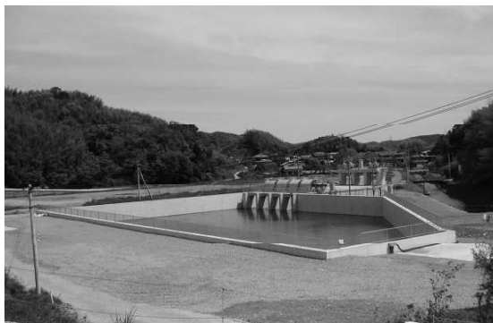
呑口調整水槽（那賀川地区）
