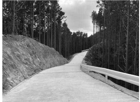
緊急輸送道路を補完する林道
