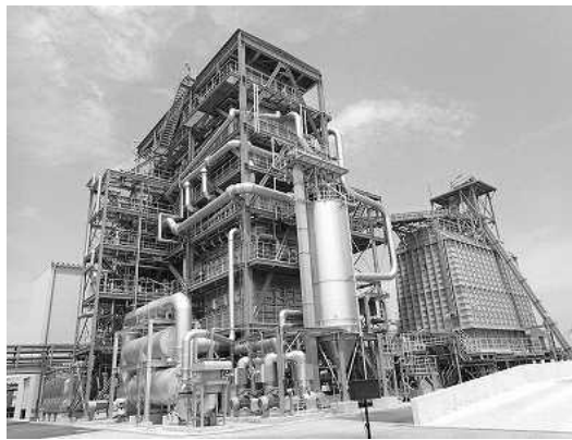
木質バイオマス発電施設
