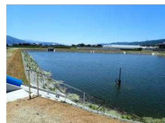
農業用ため池の整備
