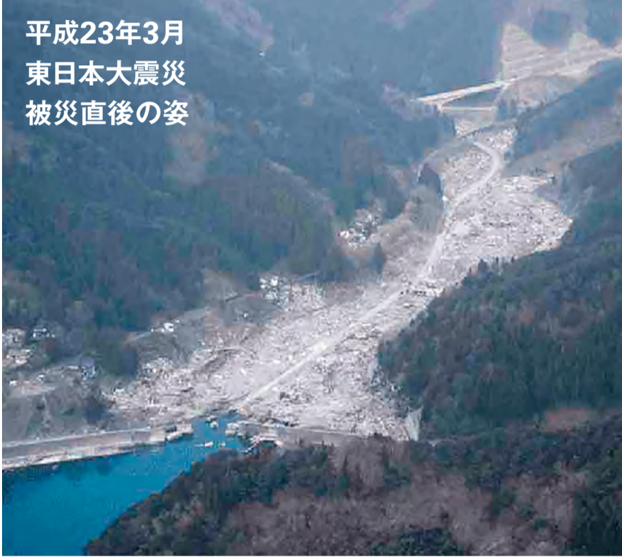
岩手県釜石市両石地区の高台移転 (出典：復興庁HP)
