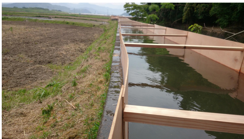
図 4－6 合板で応急処置を行った水路
