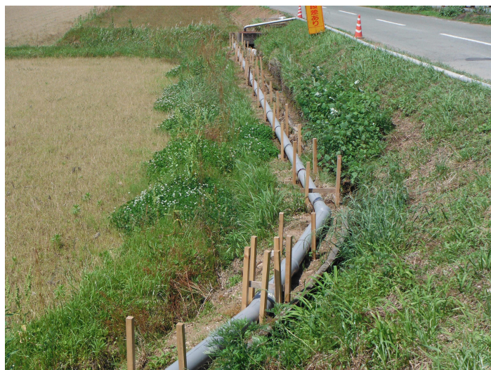
図 4－5 仮廻し水路の状況
