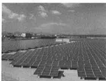
マリンピア沖洲太陽光発電所
