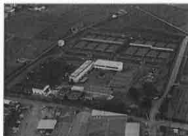
吉野川北岸工業用水道
