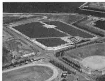
和田島太陽光発電所
