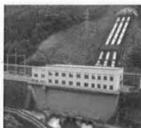
日野谷発電所
