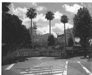
藍場町地下駐車場
