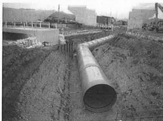
用水路のパイプライン化（国営事業）
