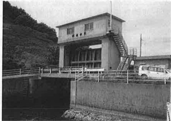
自動化された水門
