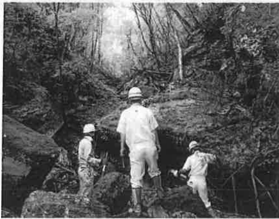
危険地区の点検
