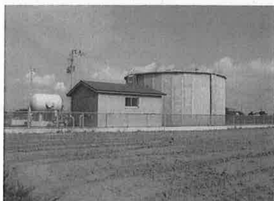
畑地かんがい施設（揚水機場）
