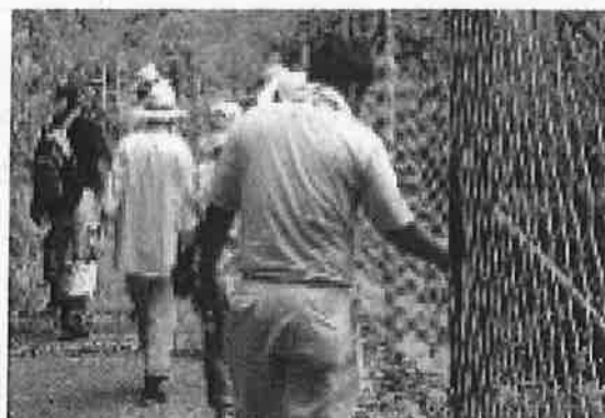
防止柵の点検
