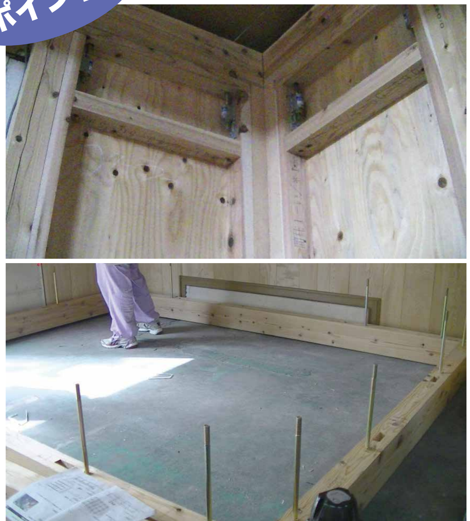
耐震シェルター設置
