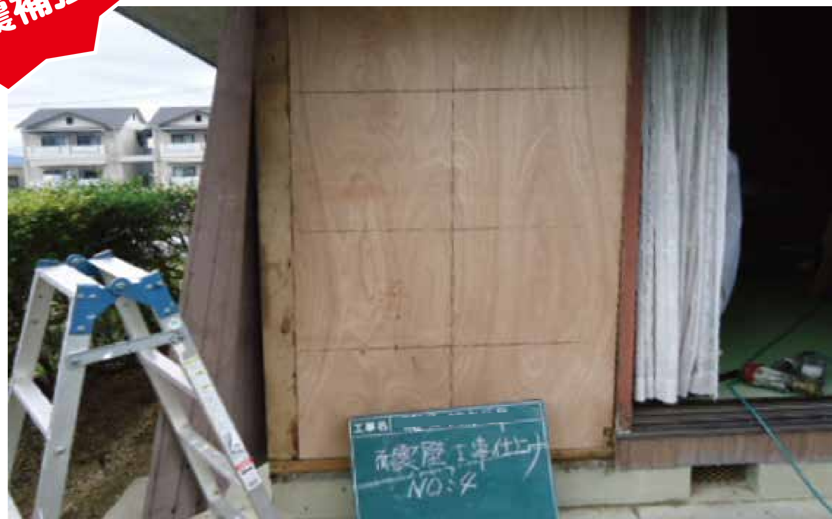
外部より耐震壁を設置
