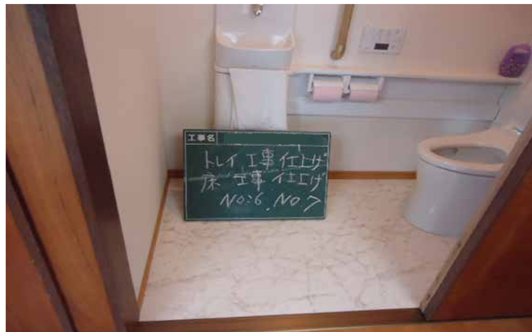
納戸から洋式トイレへ改修
