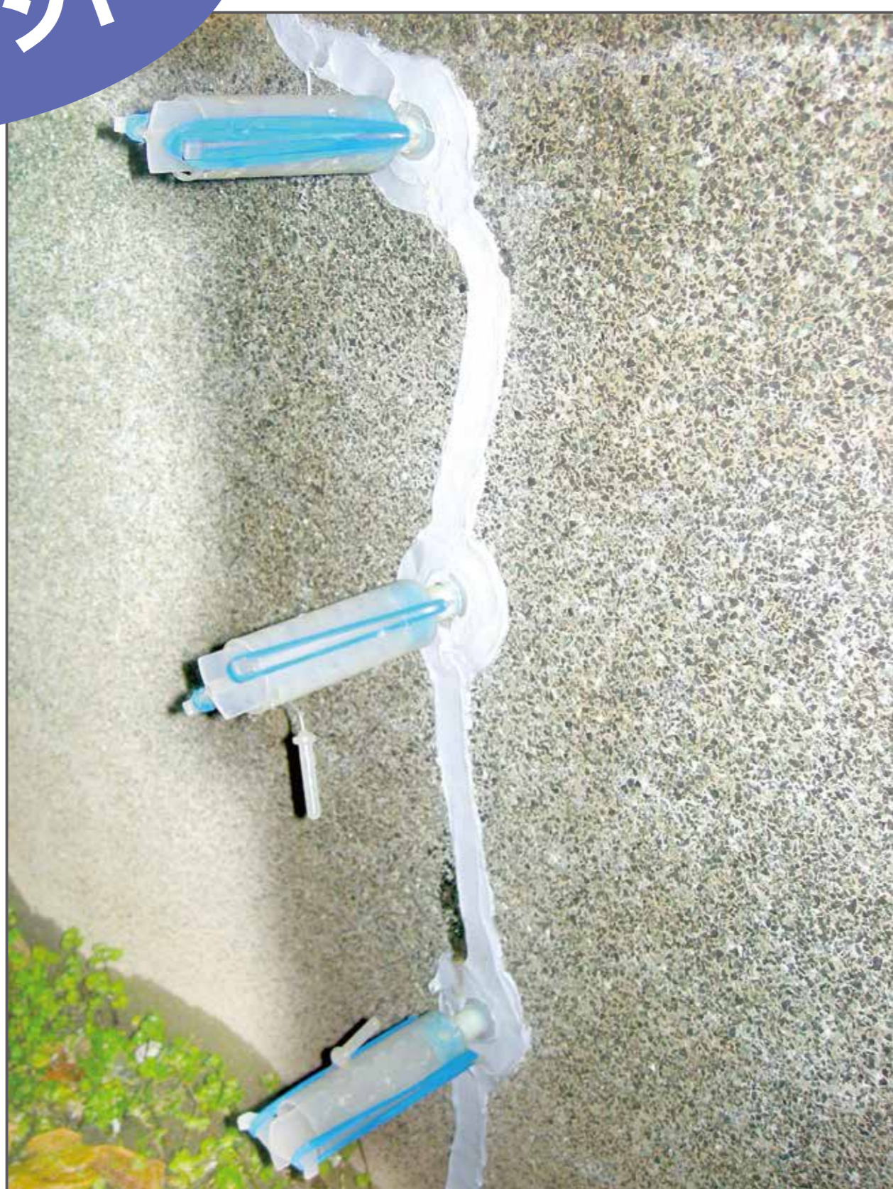
基礎ひび割れ補修(ボンドシリンダー工法)
