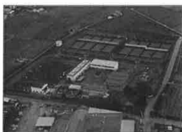
吉野川北岸工業用水道
