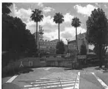
藍場町地下駐車場
