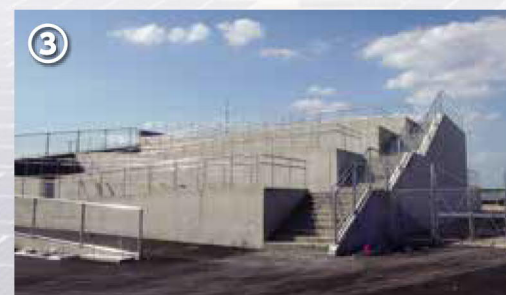
③ メガソーラーを一望できる展望台を設置(道路より5.7m高い)
