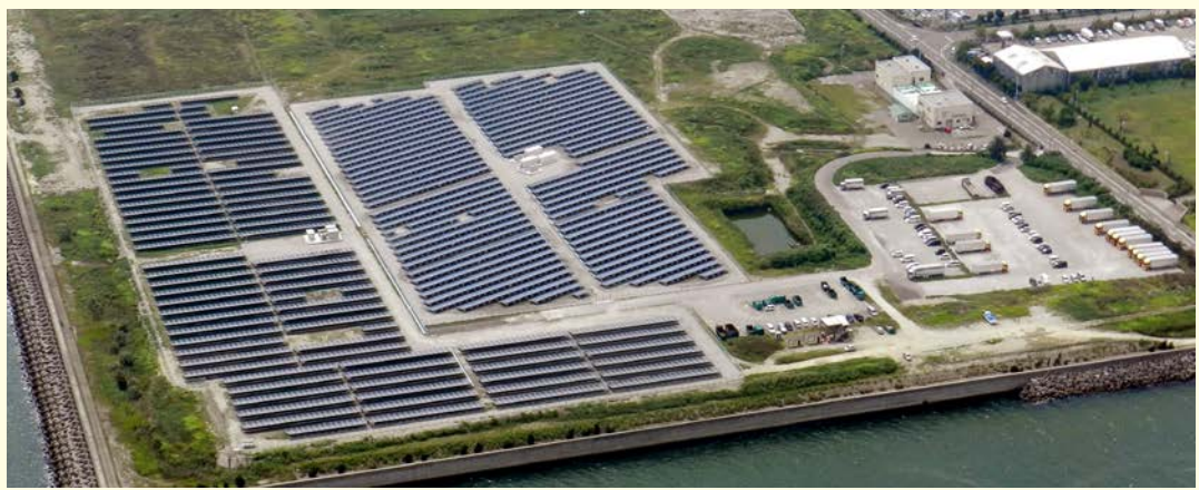
マリンピア沖洲太陽光発電所 空撮写真
