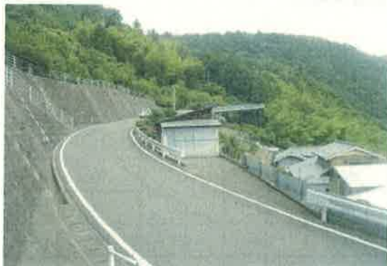
緊急輸送道を補完する農道
