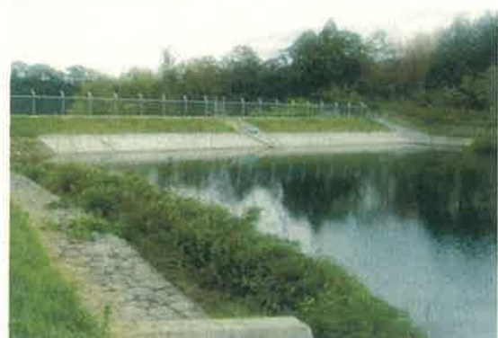
改修された農業用ため池
