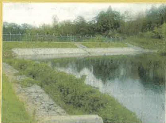
改修された農業用ため池
