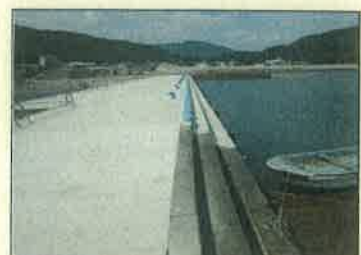
漁港における耐震岸壁の整備（牟岐漁港）
