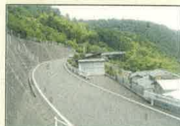
緊急輸送道路を補完する農道
