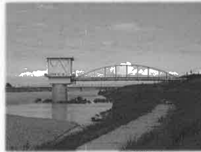
工業用水取水塔（那賀川）
