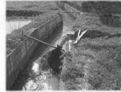
湧水時におけるポンプ取水
