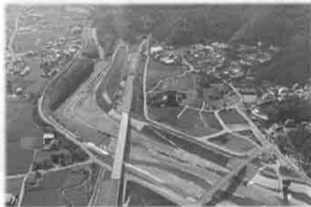
園瀬川河川改修
