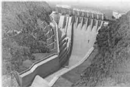
長安口ダム改造（完成イメージ）
