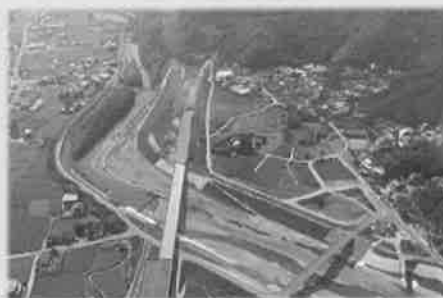
園瀬川河川改修
