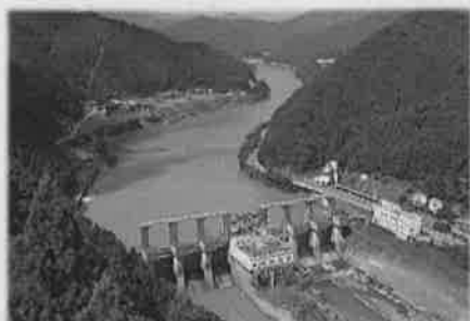
水力発電所（川口ダム）
