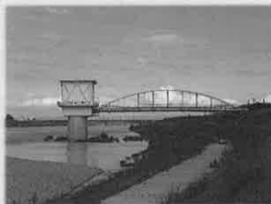
工業用水取水塔（那賀川）
