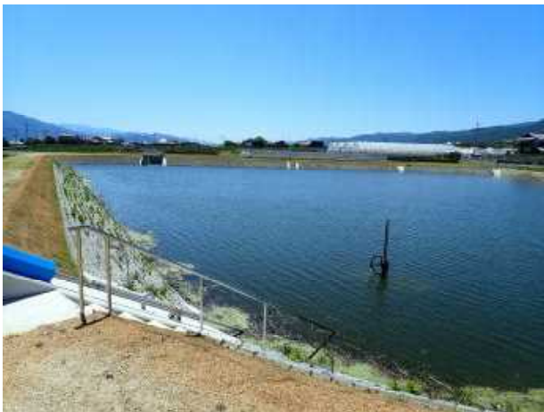
整備された農業用ため池
