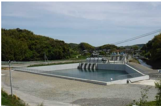
呑口調整水槽（那賀川地区）
