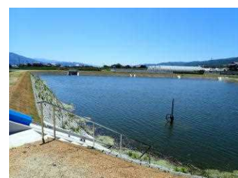
農業用ため池の整備
