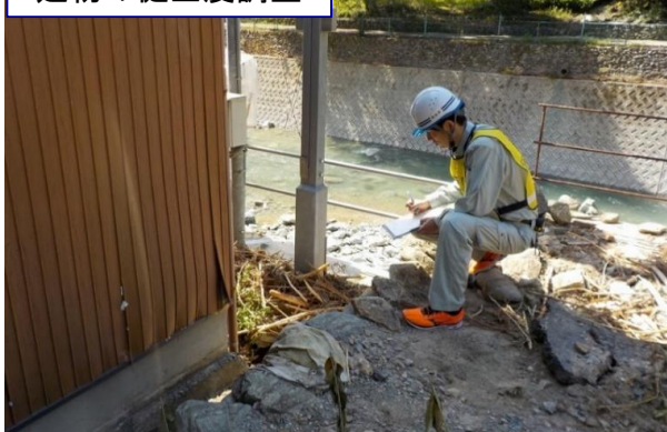
建物の健全度調査
