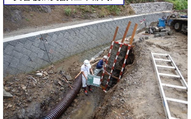
災害復旧支援（土木部門）
