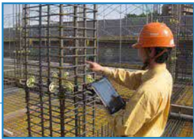
検査支援システムによる記録・管理 総括企業開発の「現場検査支援システム」で 検査箇所の確認と結果の記録・管理を行います。
