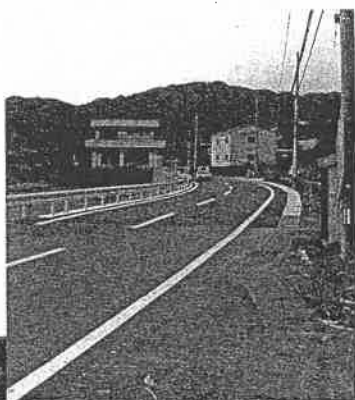
新浜勝浦線星谷工区
