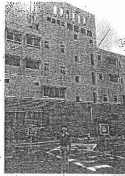
2020年7月28日 旧海部病院を改修、30床の宿泊療養施設として活用します。
