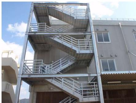
▲研究防災棟には発災時に屋上に避難するための階段が設置されています。キュービクル、自家発電装置、冷蔵庫は破碎時でも稼働できるように3階に設置されています。
