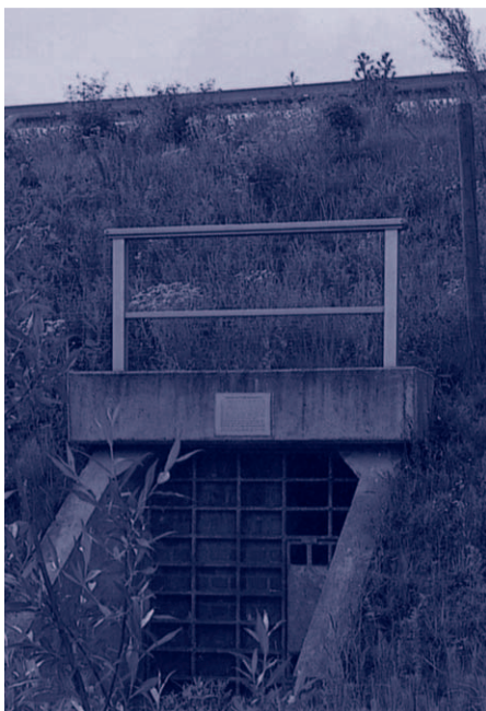
アウトバーンの法面につくられたコウモリのための洞穴。
