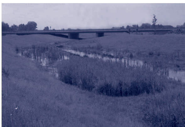
低水路の幅を変化させ、湿性植物を誘致して、多くの野生生物の生息・生育できる川にしている。 (ミュンヘン空港放水路)
