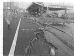
津波により瓦礫が押し寄せた魚市場(宮城県)
