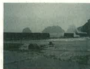
台風で損壊した防波堤 (中央漁港)
