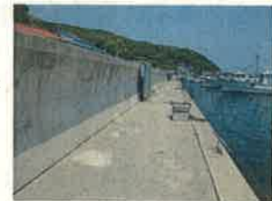
護岸（椿泊漁港）
