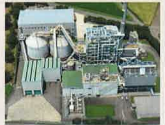
鶏ふんのエネルギー 利用施設
