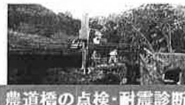
農道橋の点検・耐震診断
