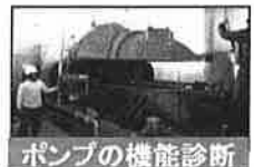
ポンプの機能診断
