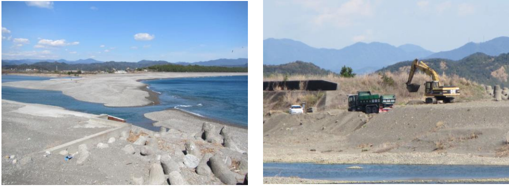
写真 4-1 砂州の維持掘削
