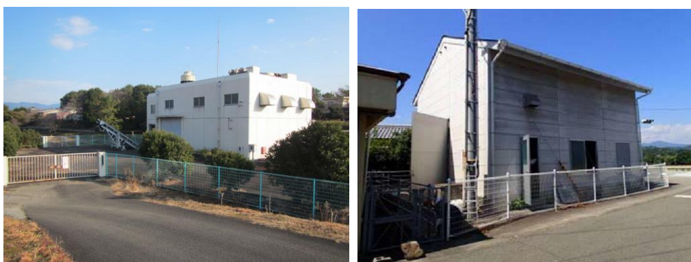
写真 4-2 排水機場の状況（左：善蔵川排水機場，右：海部川排水機場）
