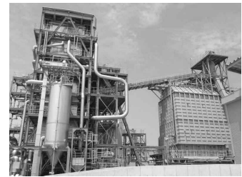
※クラボウ徳島バイオマス発電所
