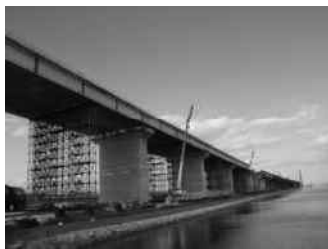
※四国横断自動車道（沖洲高架橋工事）
