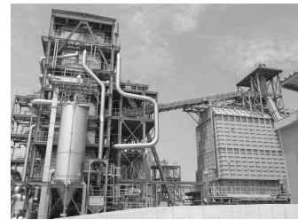
※クラボウ徳島バイオマス発電所
