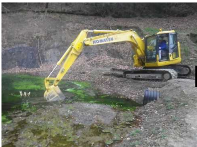
<移設状況(ため池)>
